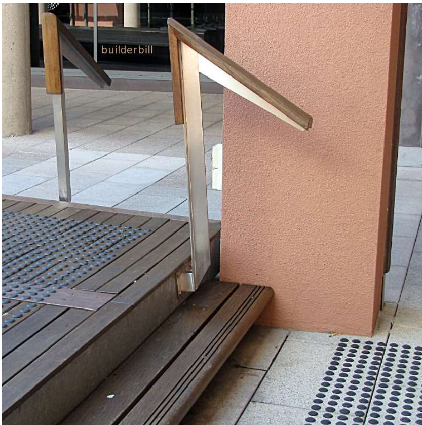
Img 6.1.2: Tactile pads
